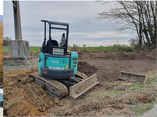
Restructuration complète du calvaire de Vaubadon
