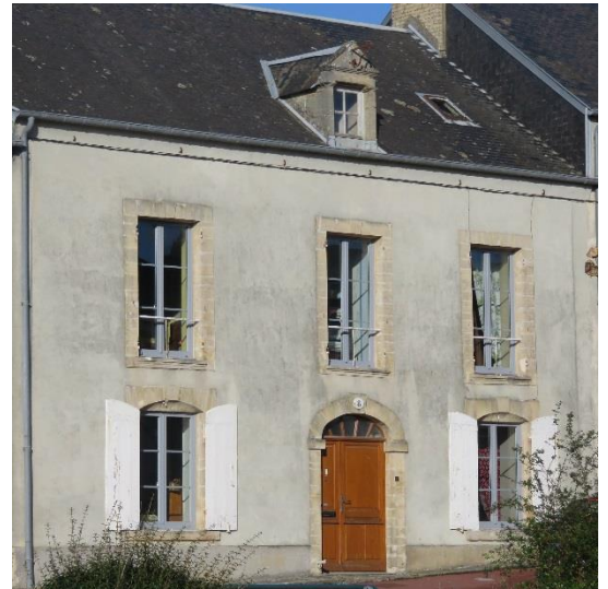
▲ Exemple de maison de la rue du Sapin, avec appareillage de schiste apparent ou enduit et encadrement des ouvertures en pierre calcaire. © Photos ERG, 2018.
