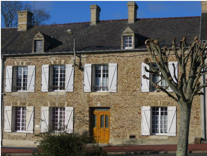
▲ Exemple de maison de la rue du Sapin, avec appareillage de schiste apparent ou enduit et encadrement des ouvertures en pierre calcaire. © Photos ERG, 2018.
